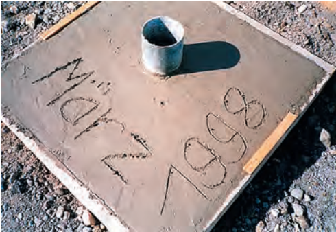
Betonieren der Pfostenhalterung
