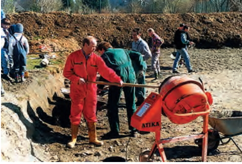
Betonieren der Pfostenhalterung
