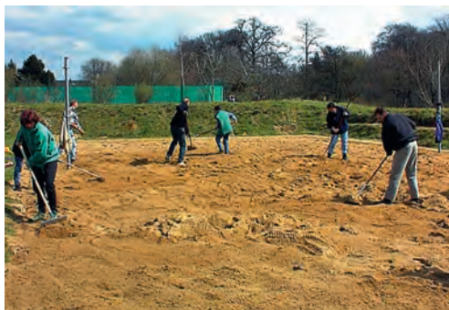
Anschließend wurde die Fläche begradigt
