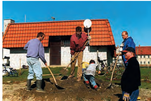
Einbringen und Verteilen des Mineralgemischs
