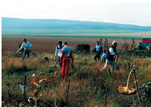
Vorbereitungen für den Bau des dritten Platzes, Foto eines Arbeitseinsatzes
