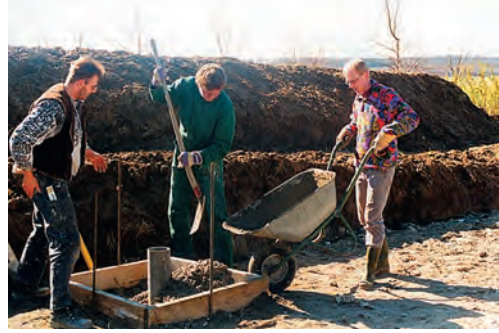
Betonieren der Pfostenhalterung
