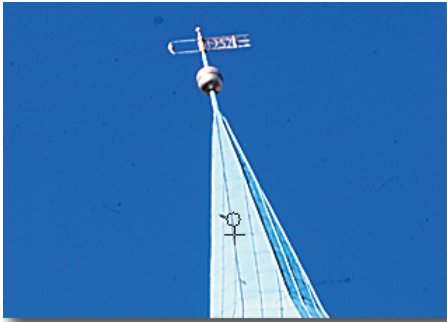
Abb. 3.8 Zutupfen des fehlerhaften Bereichs
